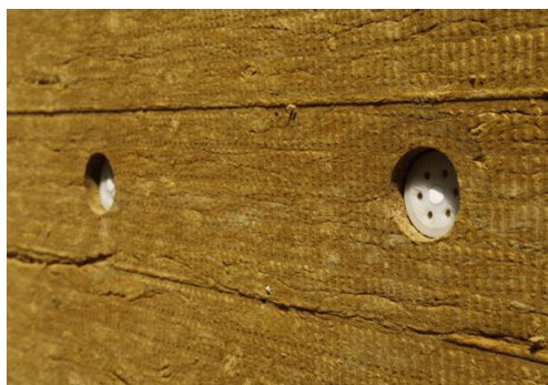
ILUSTRAČNÁ FOTKA - Ukážka montáže zapustenia rozperných kotiev
