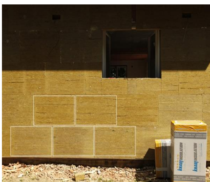
ILUSTRAČNÁ FOTKA - Ukážka správneho uloženia dosiek na stene
