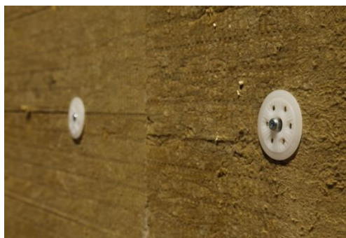
ILUSTRAČNÁ FOTKA - Ukážka vloženia rozpernej kotvy do predvrtaných otvorov
