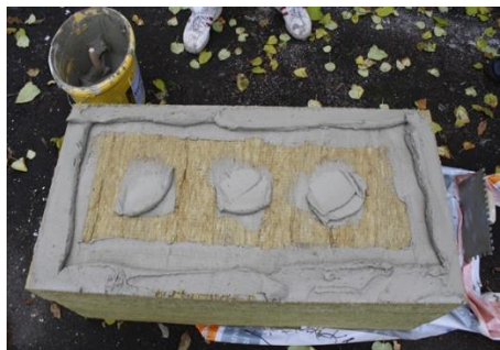
ILUSTRAČNÁ FOTKA - Ukážka správneho nanosenia lepidla na fasádnú dosku
