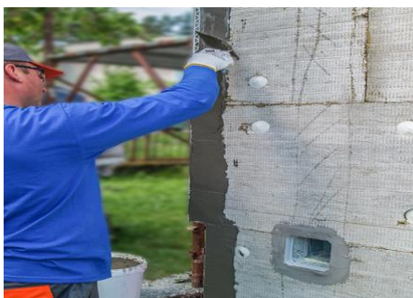
ILUSTRAČNÁ FOTKA - Osadenie rohovej lišty
