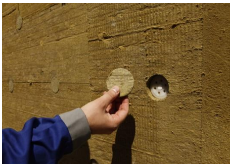
ILUSTRAČNÁ FOTKA - Zátka pre zapustenie montáž rozperných kotiev
