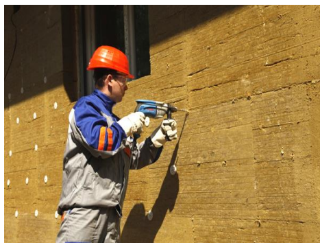
ILUSTRAČNÁ FOTKA - Ukážka vrtania otvorov - kolmo na stenu
