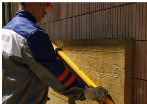
ILUSTRAČNÁ FOTKA - Nivelácia dosky pri lepení na stenu
