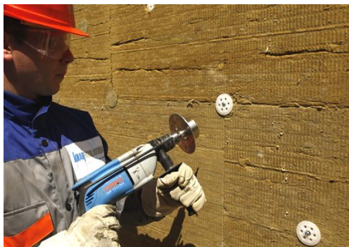
ILUSTRAČNÁ FOTKA – Ukážka prípravku na montáž zapustených rozperných kotiev
