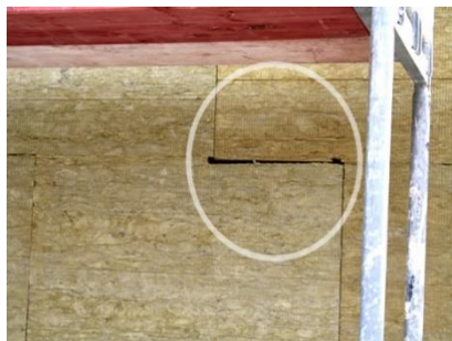
ILUSTRAČNÁ FOTKA - Medzera medzi doskami izolácie - vzniká tepelný most
