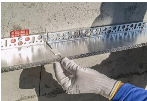
ILUSTRAČNÁ FOTKA - Správne založenie základacej lišty
