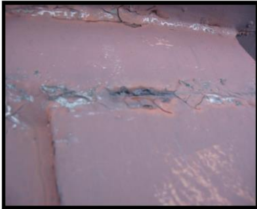
Lokálne prekorodovanie strešných nosníkov
