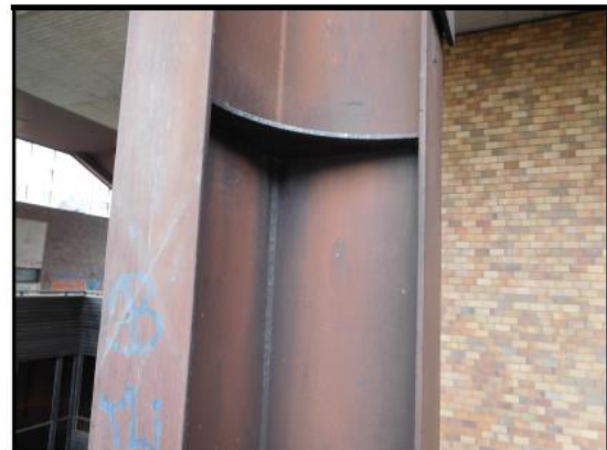
Lokálne prekorodovanie strešných nosníkov
