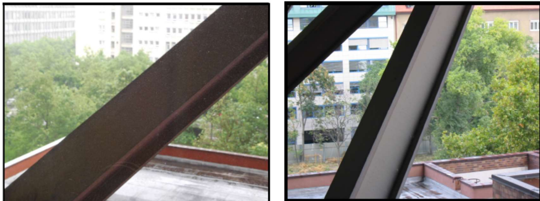
Stav povrchu HEB profilov na vnútornej strane budovy
