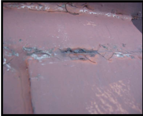
Lokálne prekorodovanie strešných nosníkov
