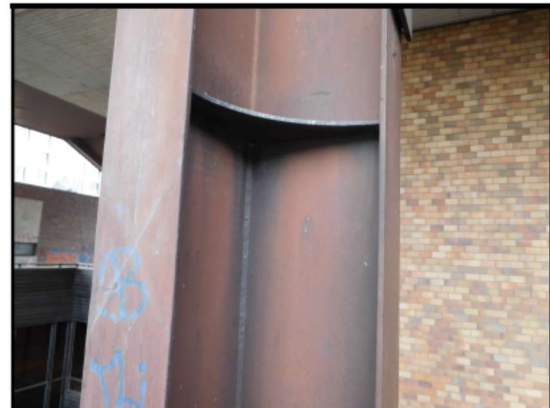
Lokálne prekorodovanie strešných nosníkov
