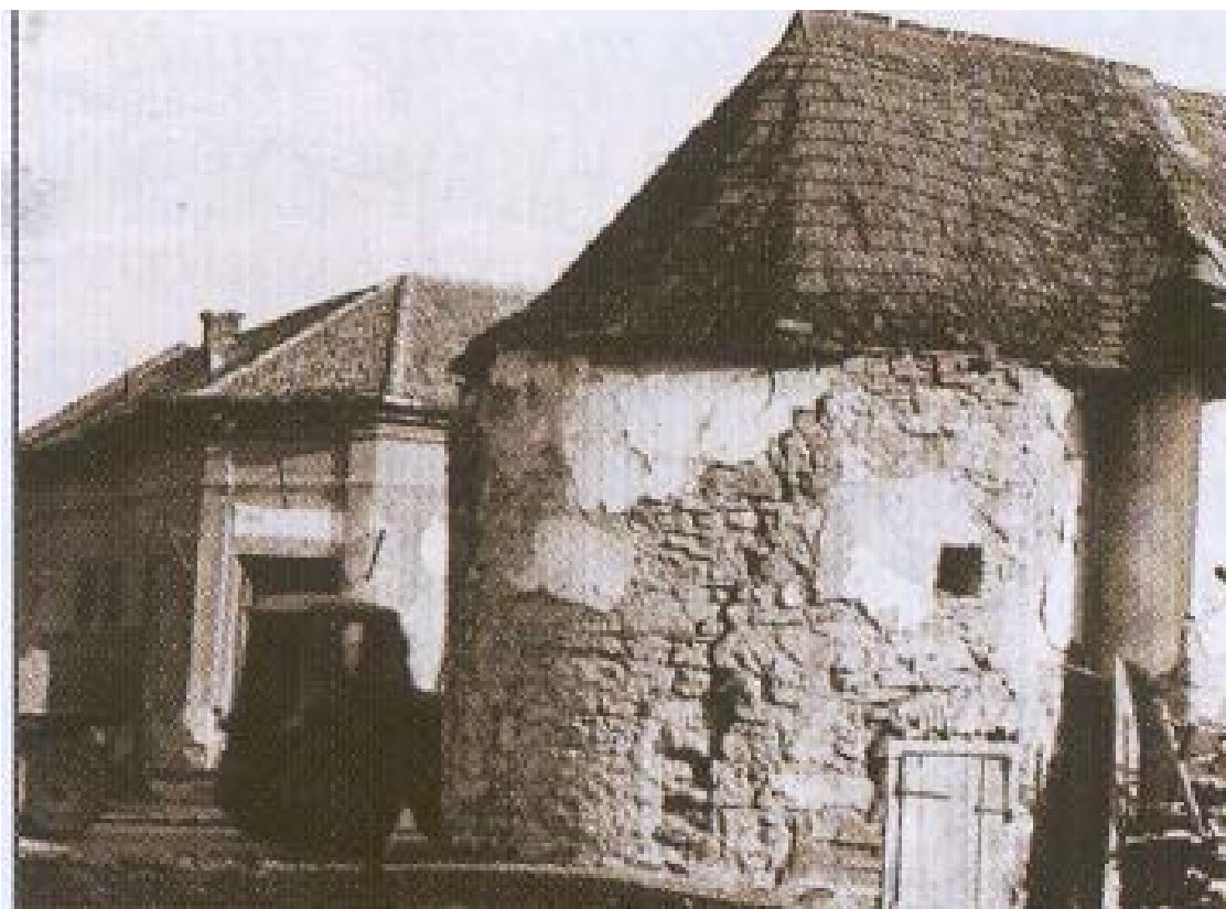
Pohľad na dnes už neexistujúcu baštu mestského opevnenia, ktorá zrejme stála na južnej strane opevnenia v blízkosti kostola.
