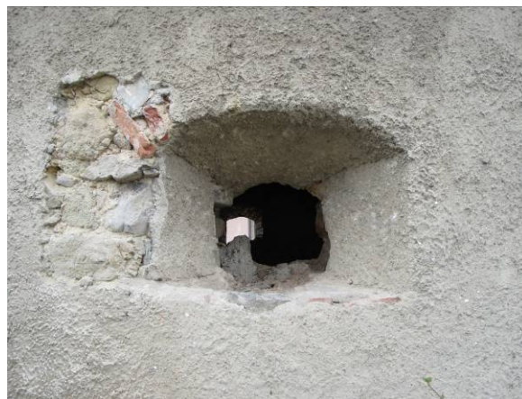
Pohľad z vonkajšej strany
