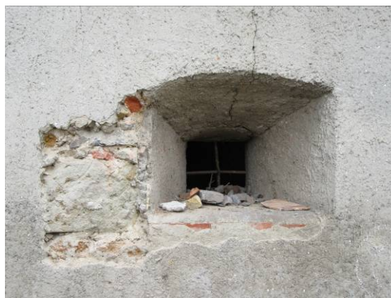
Pohľad z vonkajšej strany
